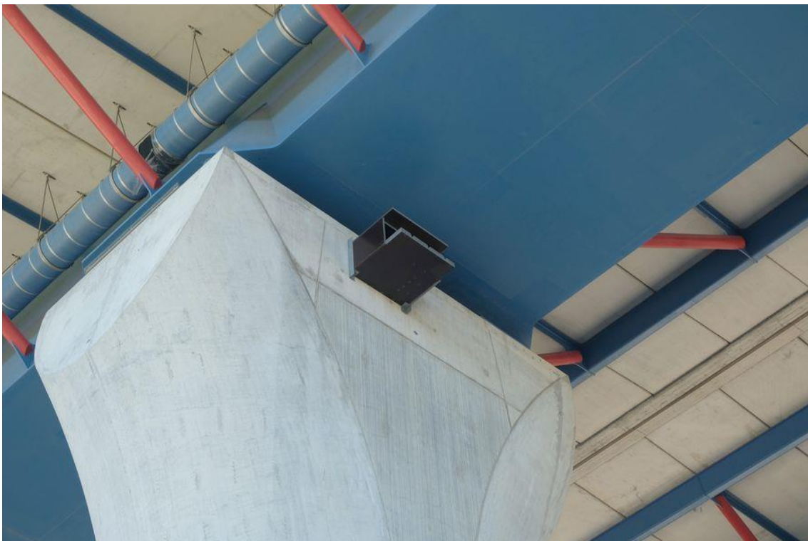
Abb. 13: Nistkasten am Pfeiler der A45-Brücke
